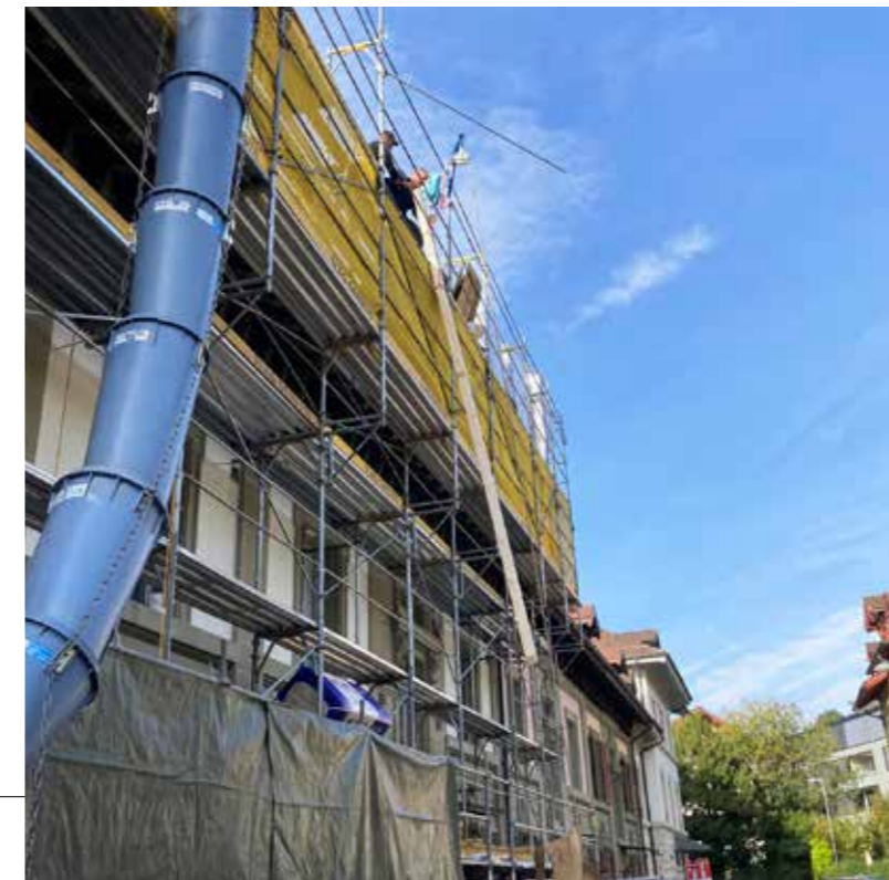
Dachsanierung am Pavillonweg in Bern.
