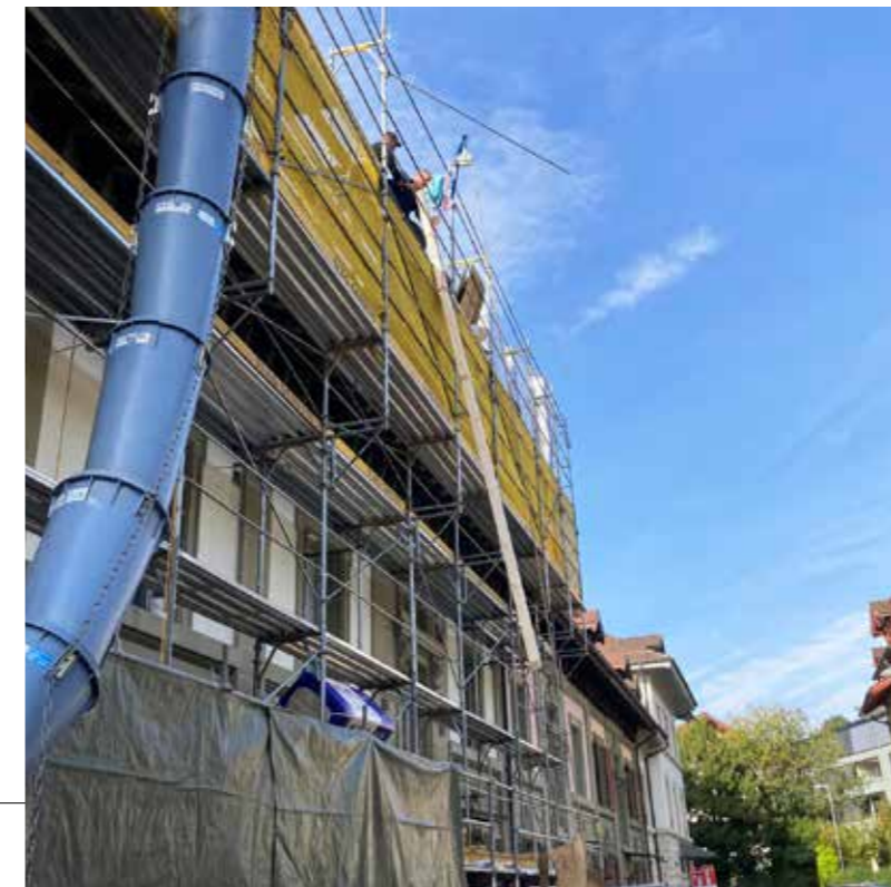
Dachsanierung am Pavillonweg in Bern.
