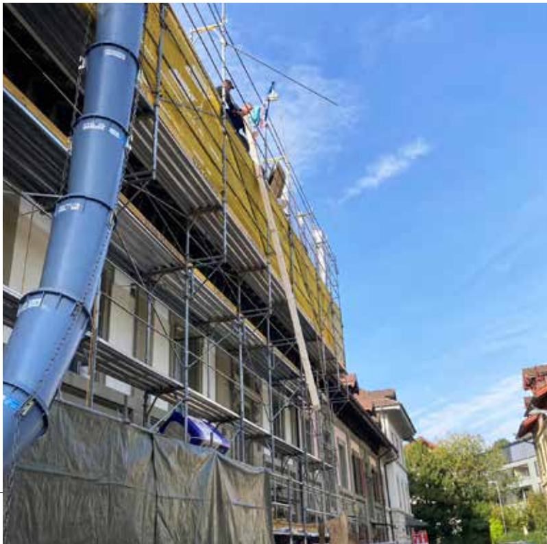
Dachsanierung am Pavillonweg in Bern.
