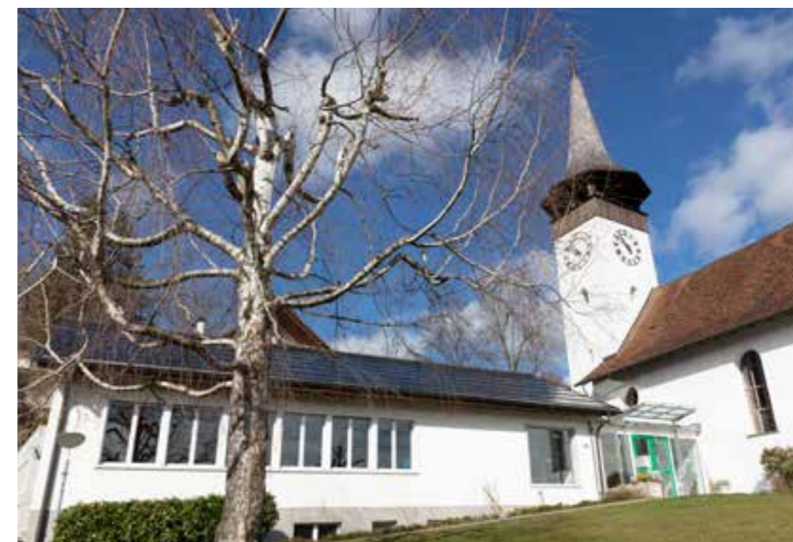
Sauvegarde de la Création: les paroisses privilégient de plus en plus les énergies renouvelables, comme le montre le toit solaire à Wattenwil.
