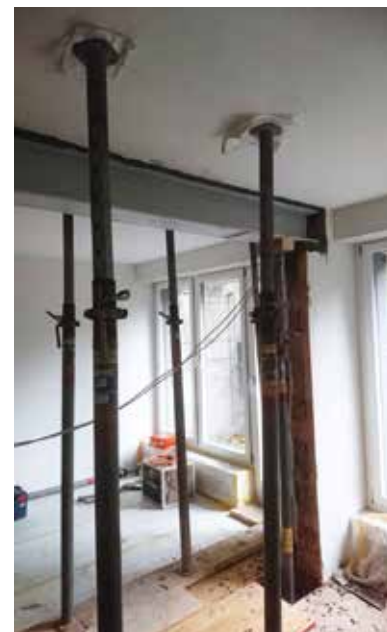
Transformation des bureaux pour le service informatique.
